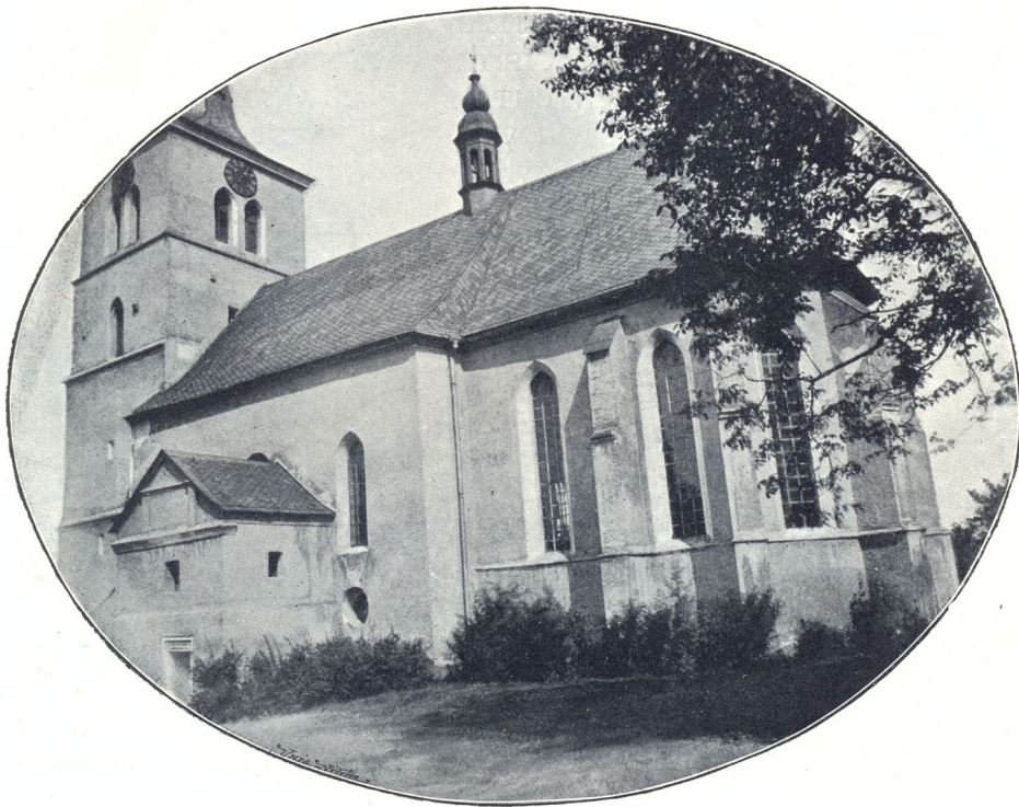
Obr. 201. Skuteč. Kostel Nanebevzetí P. Marie. (Pohled od jihovýchodu.)
