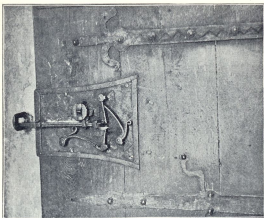
Obr. 208. Skuteč. Kostel Nanebevzetí P. Marie. Zámek a závěsy gotické na dveřích do sakristie.
